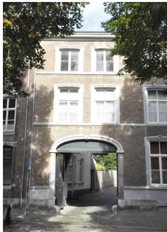
Toegangspoort Grote Looiersstraat
