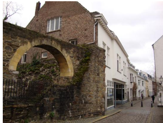
Deel stadsomwalling naast pand Looiersgracht 1
